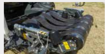
Sistema de pesagem
